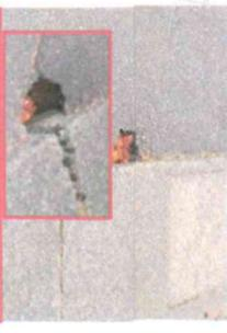
歩道の舗装下の路盤が流出しているように見える
